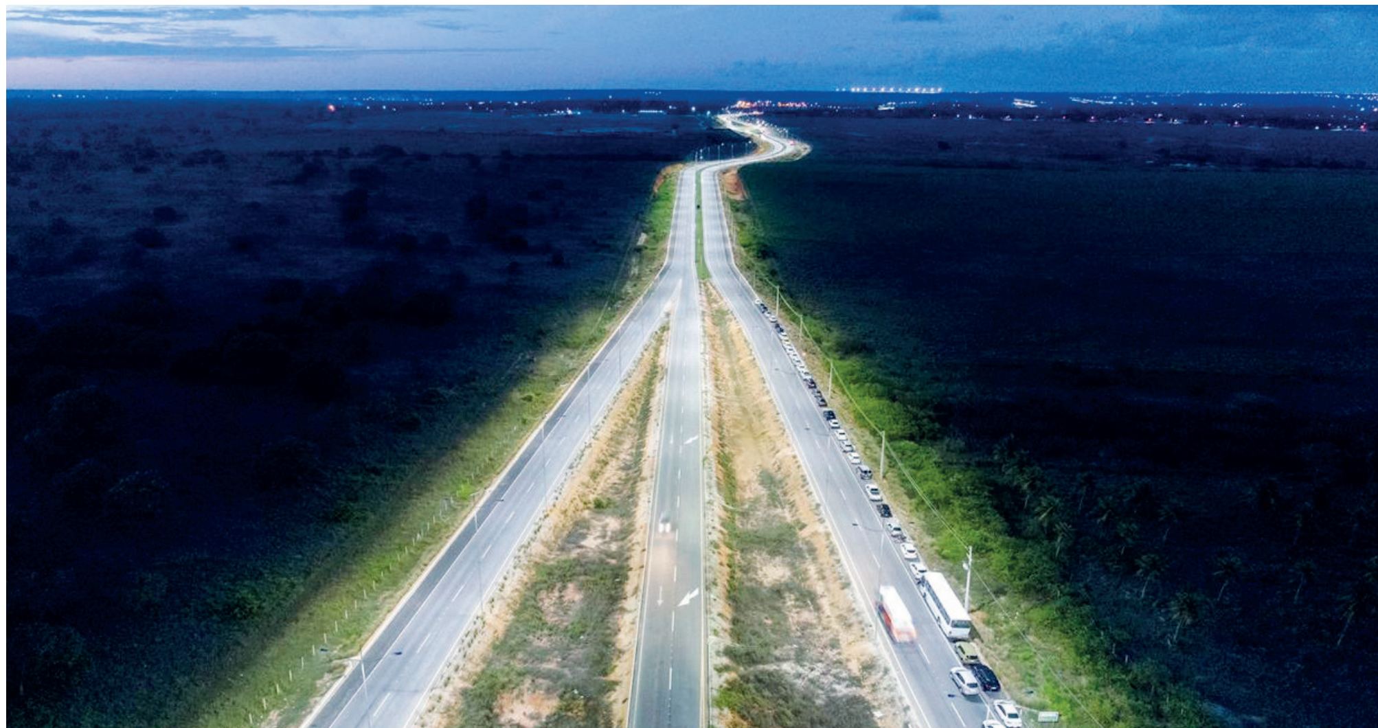
Obra foi executada pela Companhia Energética do Rio Grande do Norte (Cosern), e funcionava desde o último dia 14 de janeiro em fase experimental. Ao todo, foram implantados 254 postes e 23 transformadores
