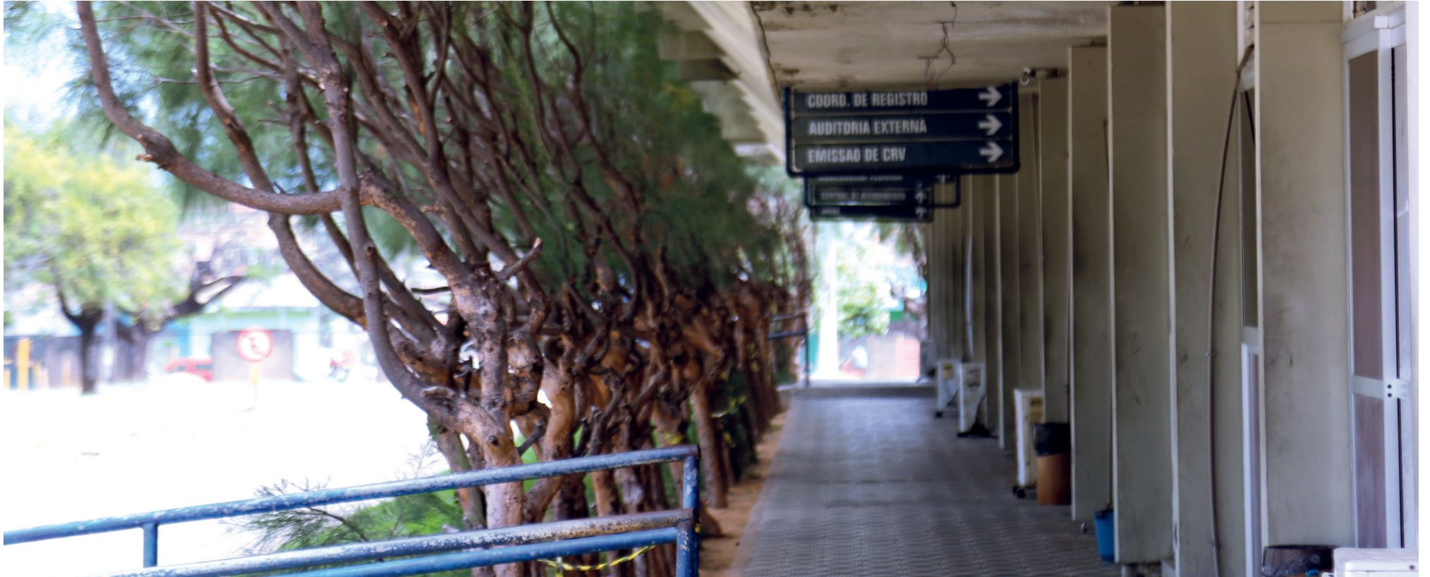
A reestruturação da sede do Departamento Estadual de Trânsito contempla outras etapas. A segunda fase das ações, com previsão para ser licitada em 2021, vai beneficiar o setor de registro e de atendimento ao público
