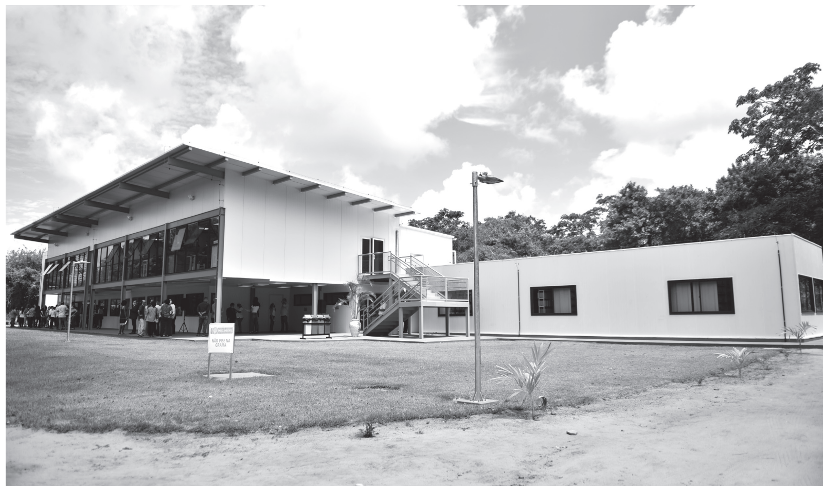
Construção do Anexo Administrativo foi conduzida e fiscalizada à íntegra pelo Idema. Obra foi acompanhada pelo engenheiro e servidor do Idema Abelardo Alves Correia e teve início em 2019
