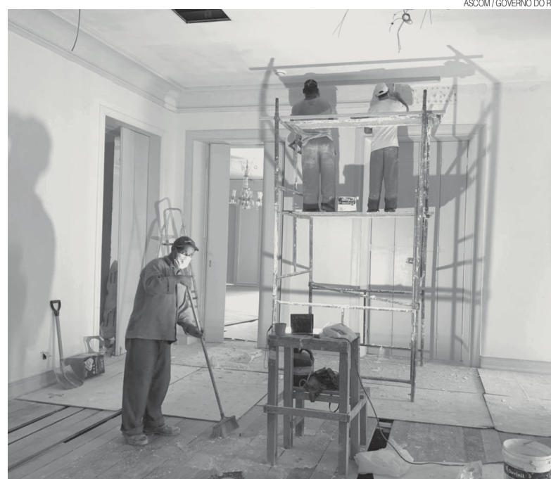
Governo atual encontrou apenas 5% das obras executadas e entraves que dificultavam o serviço
