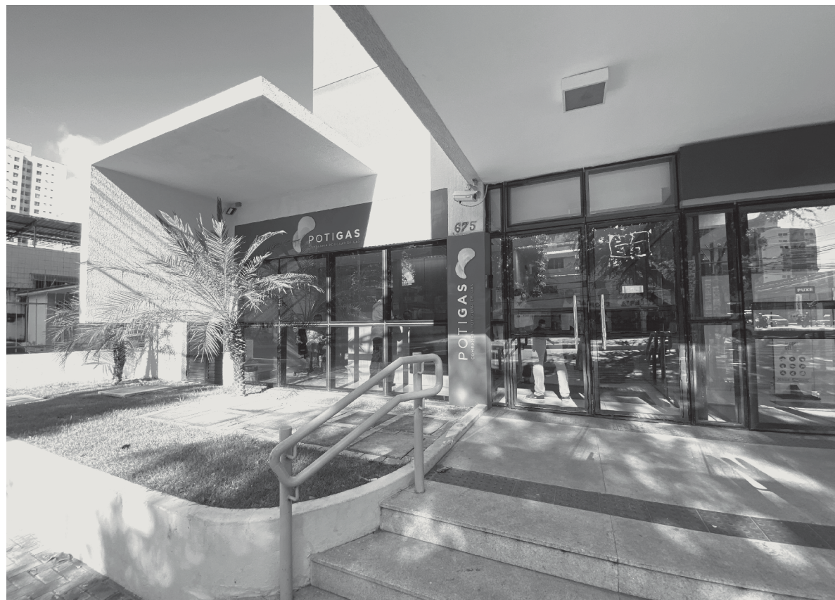
Serviços de distribuição de gás natural canalizado são feitos pela Companhia Potiguar de Gás (Potigás) no Rio Grande do Norte
