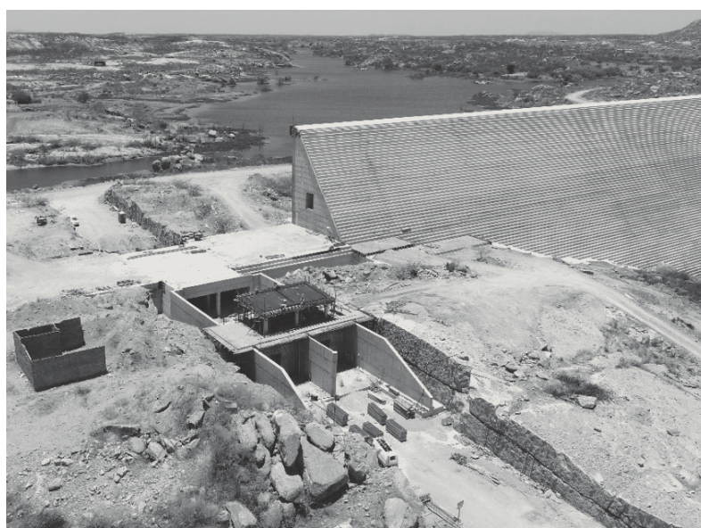
Barragem de Oiticica é a maior obra de infraestrutura hídrica em andamento no RN
