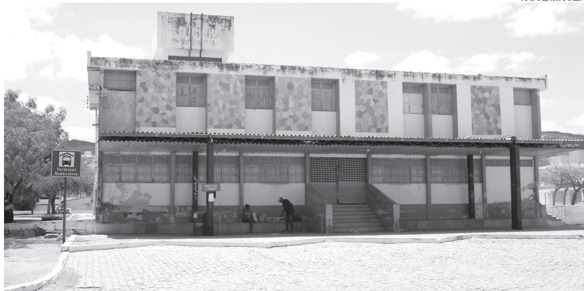
Governadora autoriza reforma da rodoviária e da ponte sobre o rio Caldeirões, em Parelhas
