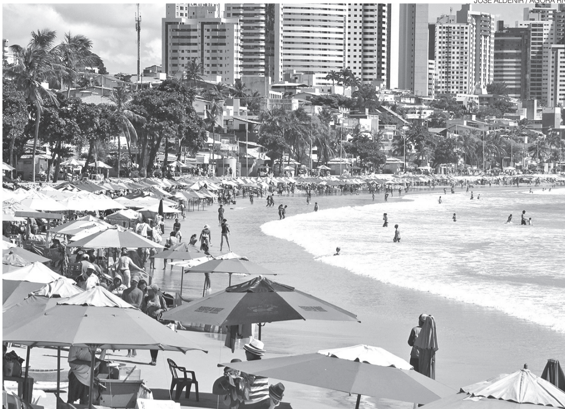
Obra vai permitir alargamento na faixa de areia da praia, com até 50 metros na maré cheia e 100 metros na maré seca
