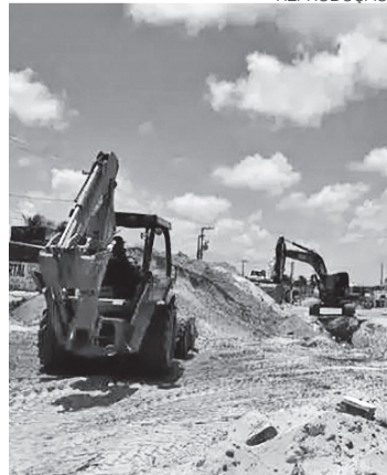
Obras na Avenida Moema Tinoco
