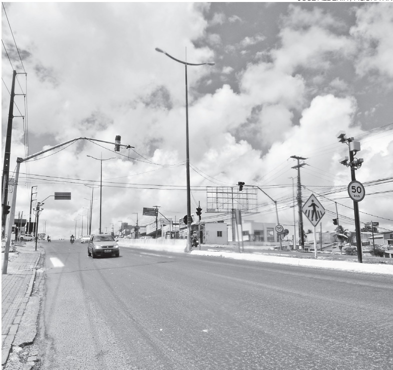
Equipamento que controla velocidade instaladona Av. Tomaz Landim (BR-101)
