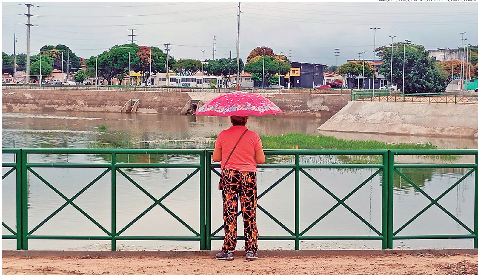
Obras no Santarém incluíram aumento da capacidade da lagoa de captação, instalação de novas bombas hidráulicas e construção de uma estação elevatória
