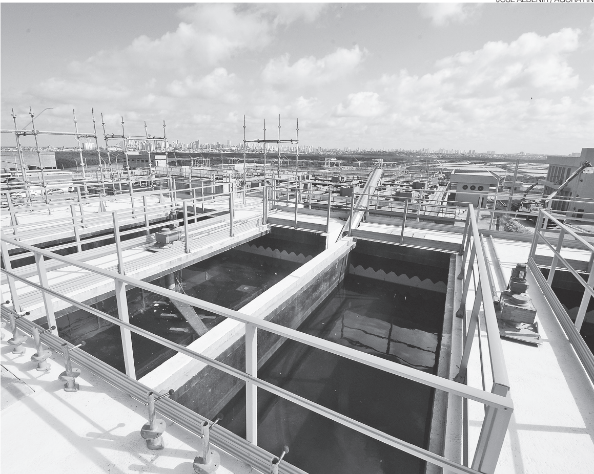
ETE Jaguaribe ampliará a cobertura de esgotamento sanitário na Zona Norte de 3% para até 95% após conclusão
