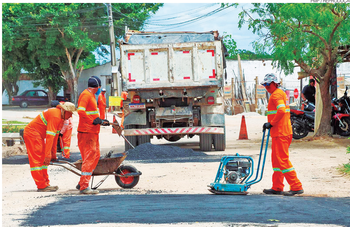
Serviços de pavimentação asfáltica foram realizados em todos os bairros, atendendo a apelos dos moradores
