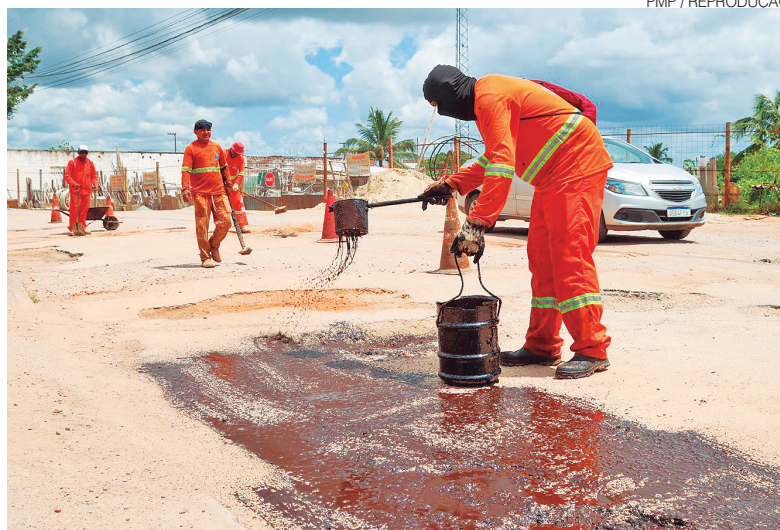
Projetos de infraestrutura estão espalhados pela cidade, em diversas áreas
