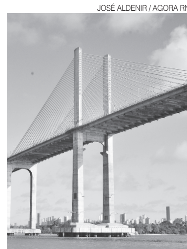
Estrutura vai proteger ponte e embarcações
