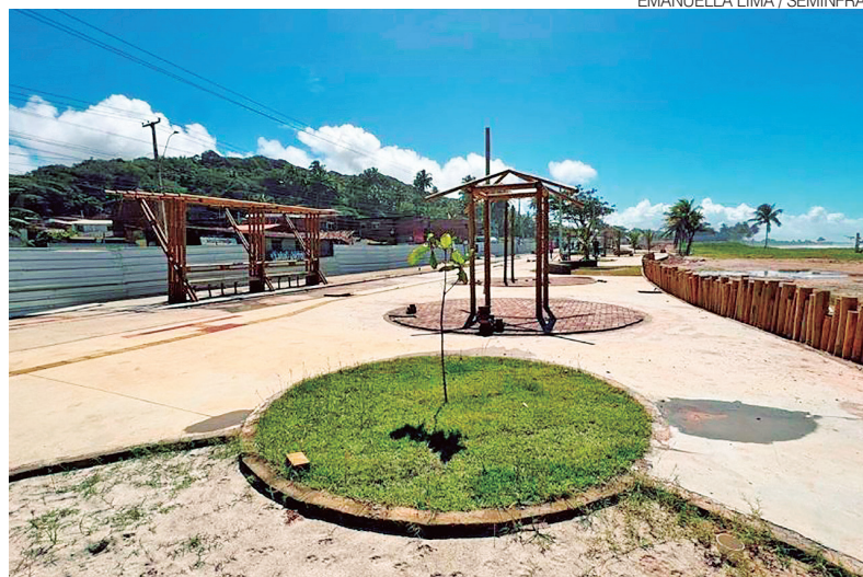
Parque Linear do Riacho Doce, em Maceió (AL), está com obras em andamento
