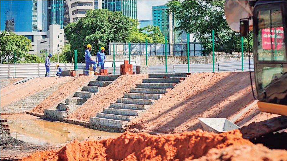
Parque Linear Roque Santeiro, em Recife, em obras; cidade tem dois parques em construção
