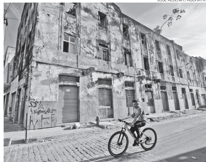
Bairro histórico da Ribeira tem prédios abandonados e com estrutura precária
