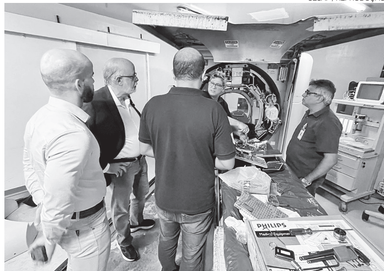
Técnicos de empresa realizam reparo em tomógrafo do Hospital Walfredo Gurgel
