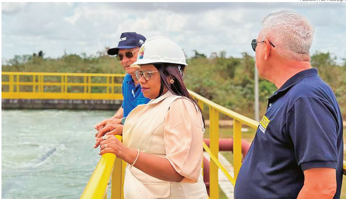
Prefeita Nilda e técnicos da gestão municipal em visita às obras da ETE, que está em obras em Passagem de Areia
