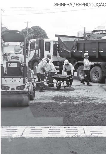
Obra está orçada em R$ 1,5 milhão
