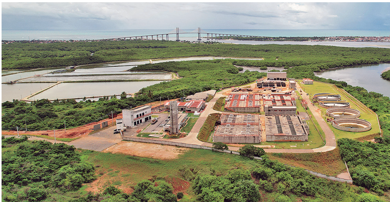
Quando entrar em funcionamento, nova Estação de Tratamento de Esgotos vai receber contribuições sanitárias domiciliares
