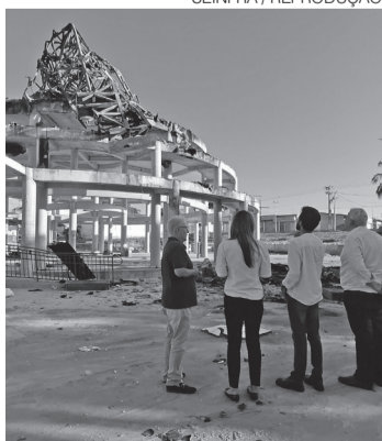
Fiscalização da Prefeitura na obra
