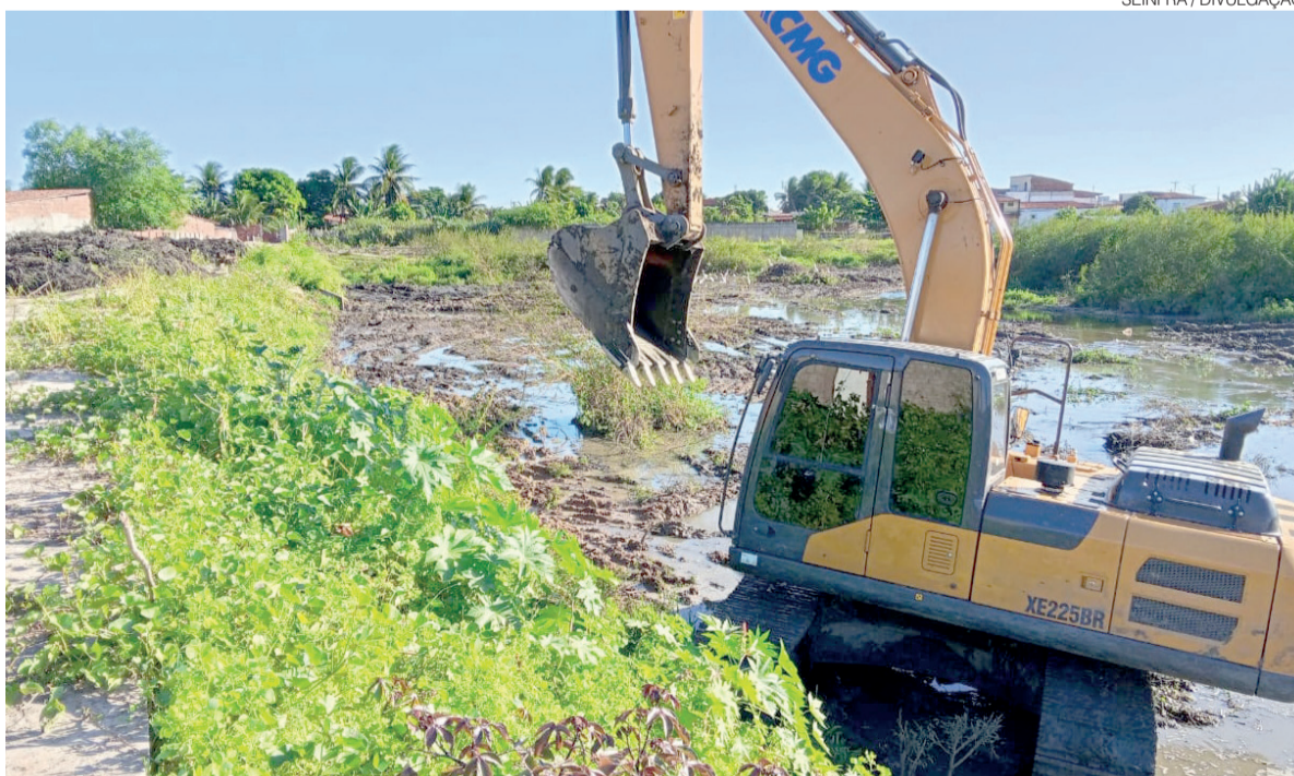
Limpeza em lagoa de captação no bairro de Soledade integra ações para ampliar a eficiência do sistema de drenagem
