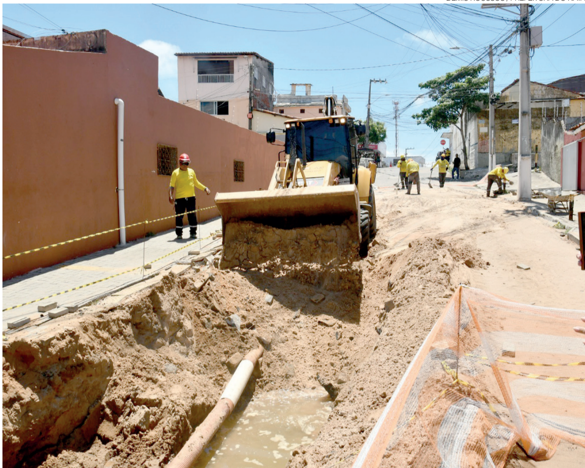
Obra de drenagem na Rua Vereador Cauby Barroca prevê substituição completa da rede para reduzir alagamentos
