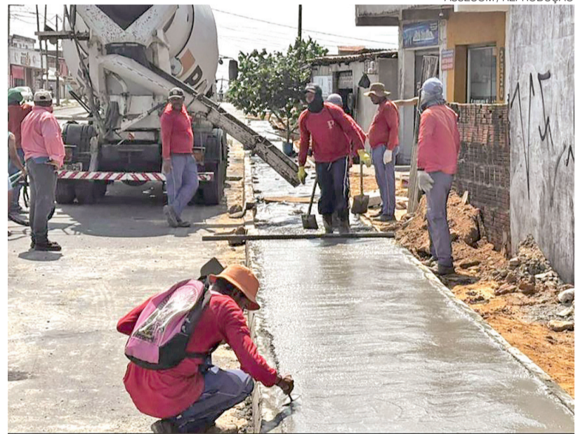
Na zona Norte, seguem em execução as intervenções da Meta 2 do Pró-Transporte
