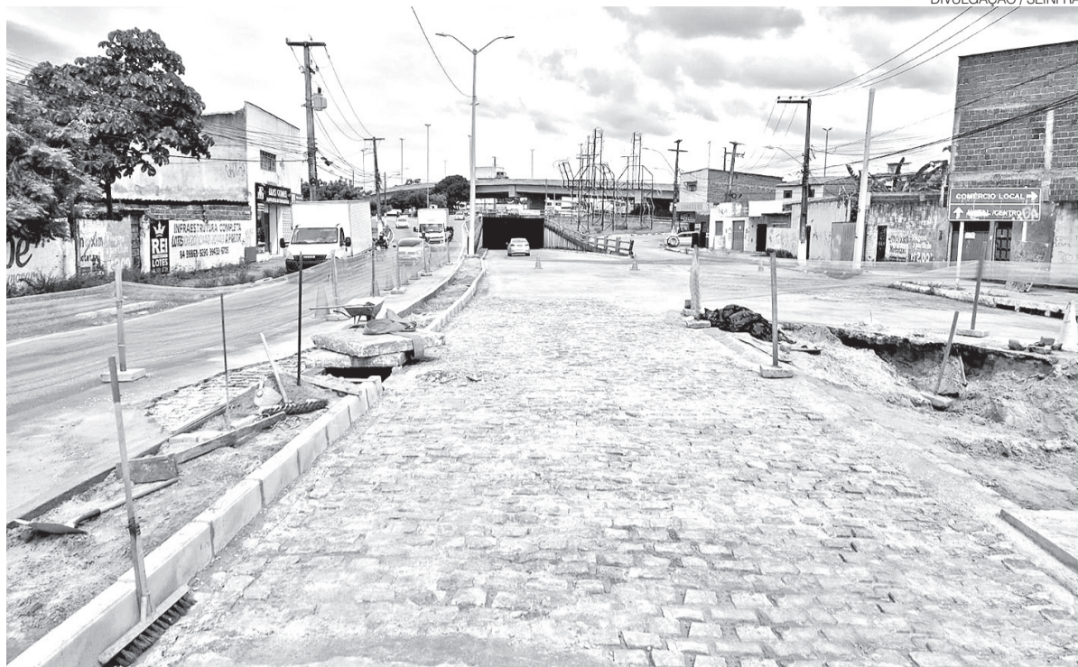
Prefeitura do Natal concluiu a recuperação emergencial da drenagem na Avenida João Medeiros Filho, na Zona Norte
