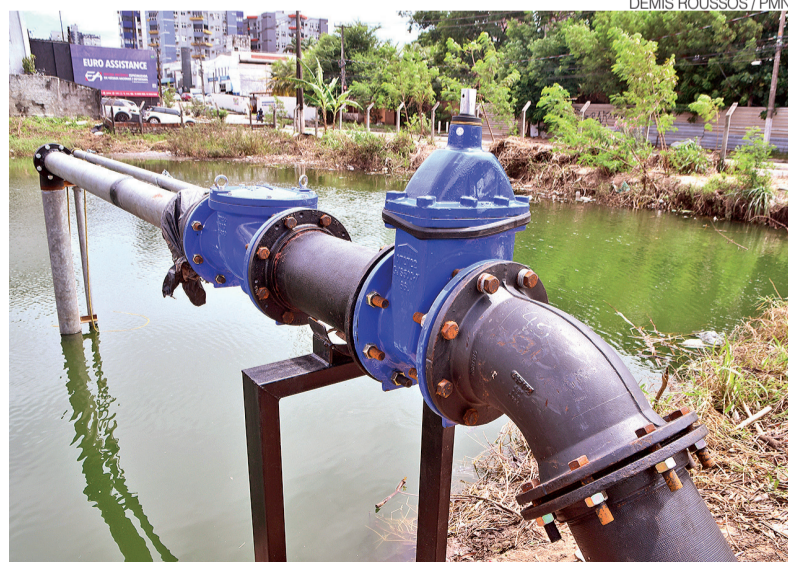
Mais de 51 mil toneladas de resíduos foram removidas das redes de drenagem
