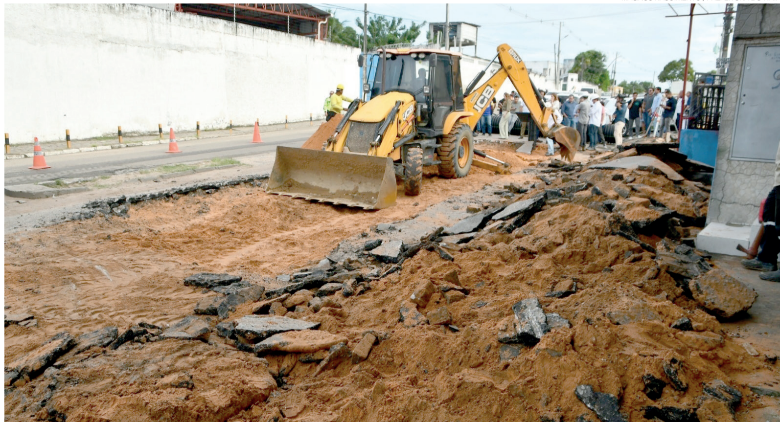
Obras na avenida Solange Nunes tiveram início há poucos dias e contam com investimento de R$ 3,4 milhões em recursos próprios do Município
