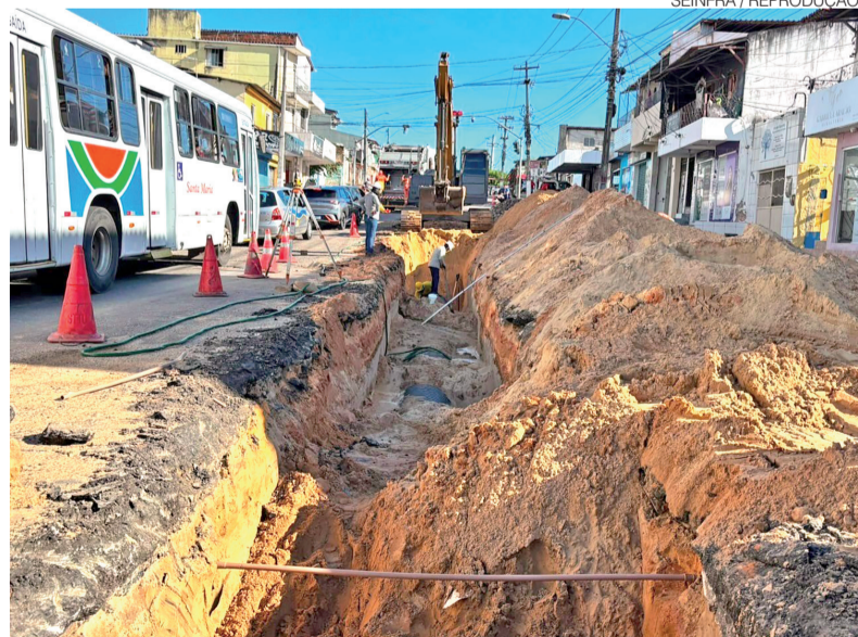
Obra realizada pela Seinfra representa solução definitiva para alagamentos na região
