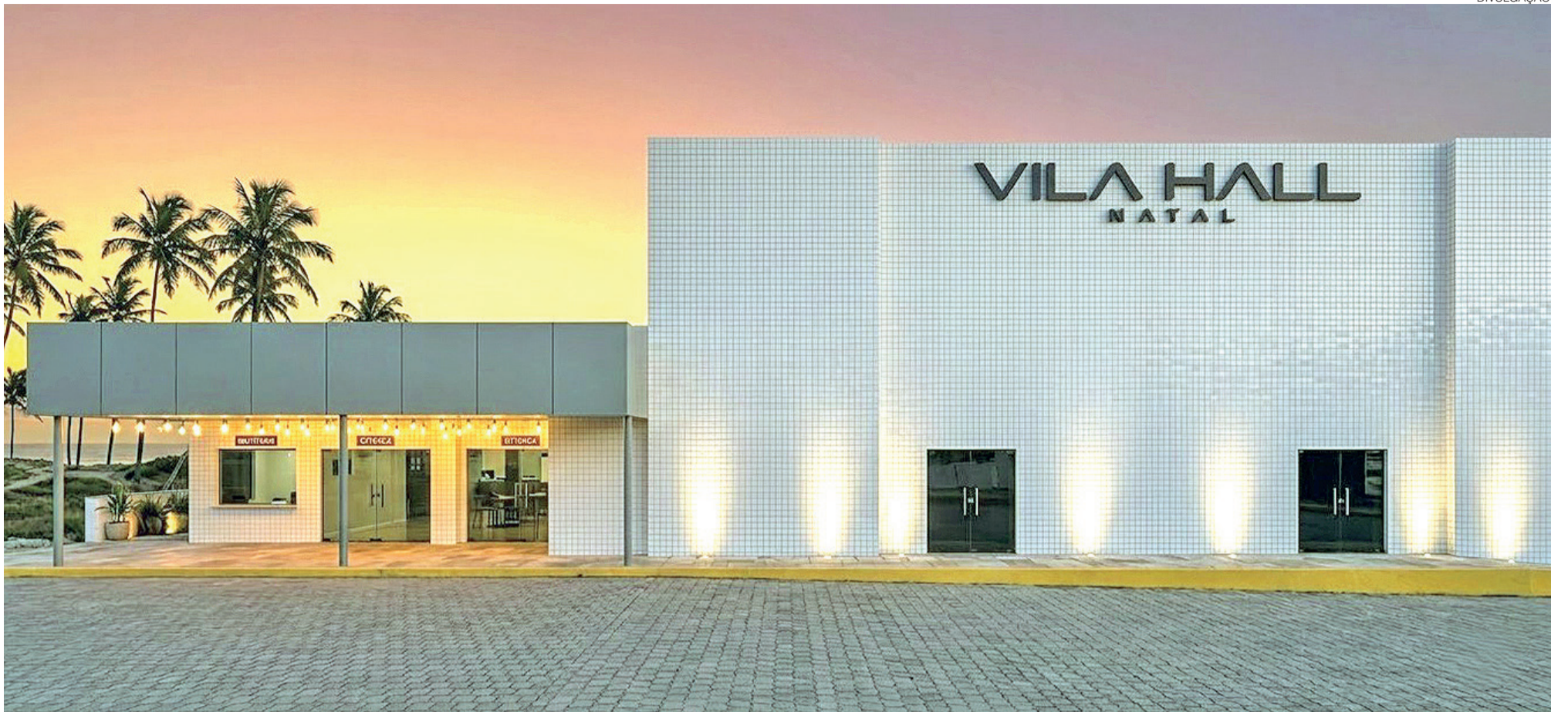
Fechado há anos, Vila Hall já passa por obras de reestruturação e deverá reabrir até o fim de 2026 como teatro multiuso na Via Costeira sob gestão da Idearte — empresa do produtor Amaury Júnior
