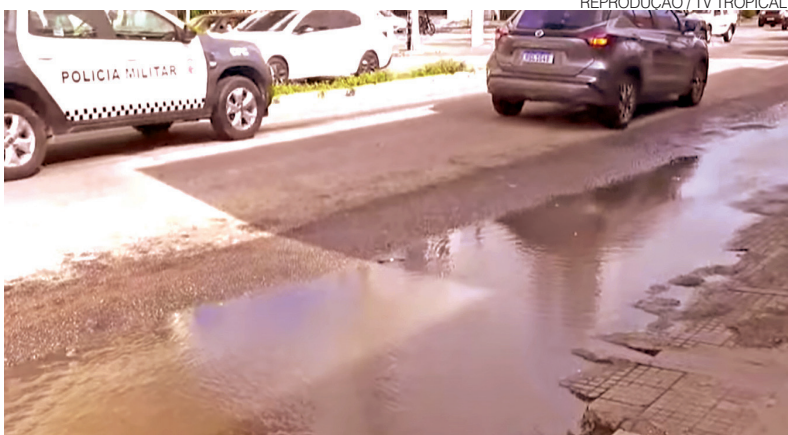
Água servida e lama na rua reduzem o espaço para circulação de pedestres
