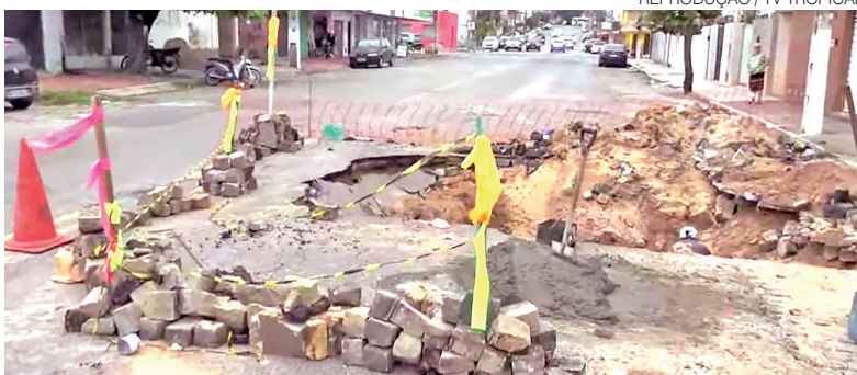
Seinfra fará o recapeamento do pavimento para liberar totalmente o tráfego
