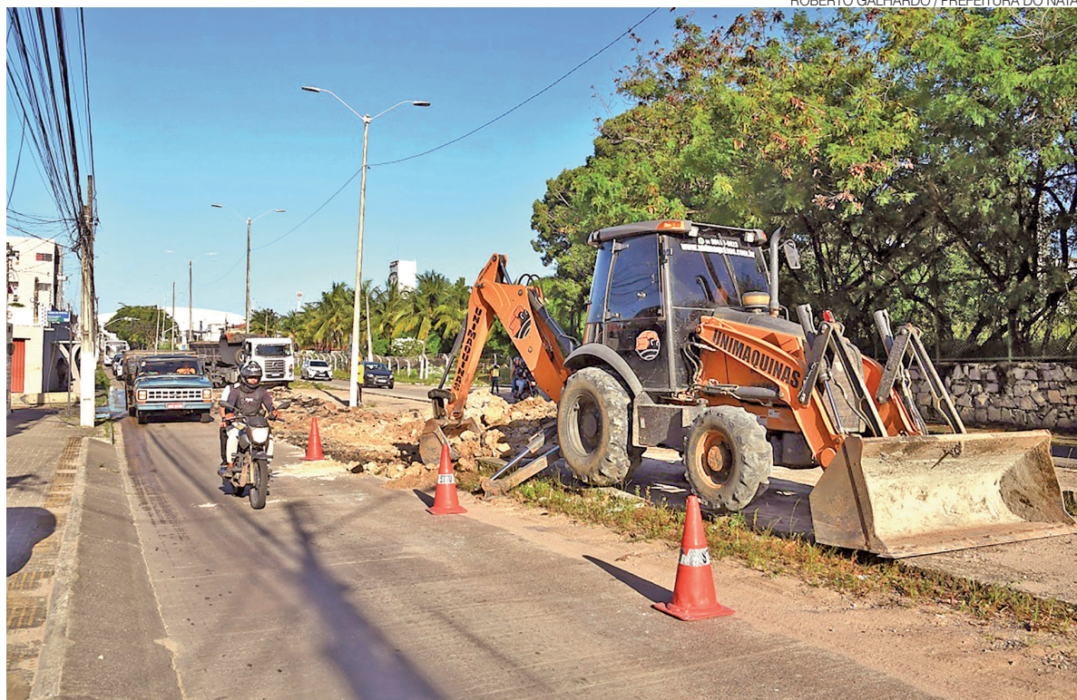
Avenida Jerônimo Câmara passa por recapeamento asfáltico em obra que contempla 2,25 quilômetros de extensão
