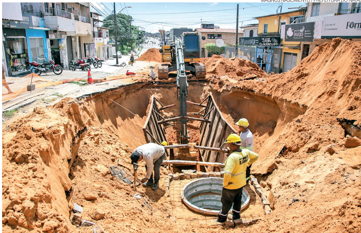
Obra de drenagem na Avenida Solange Nunes recebe investimento de R$ 3,37 milhões para eliminar alagamentos
