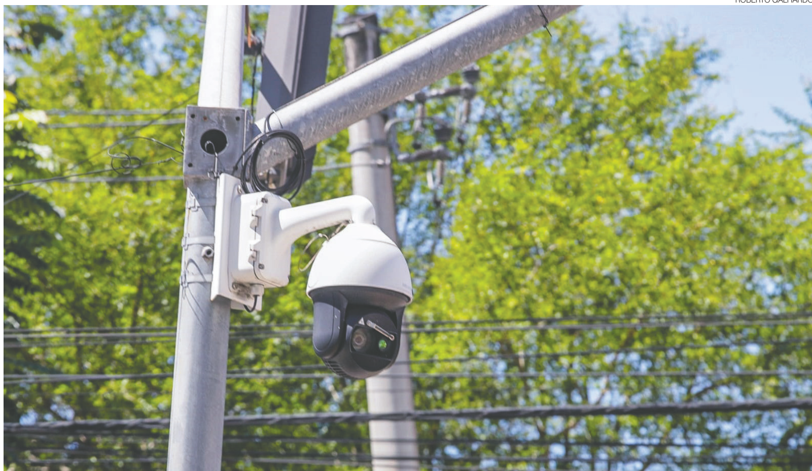
Instalação de novos equipamentos de monitoramento tem como foco preservação de vidas, respeito às normas de trânsito e melhoria da mobilidade urbana
