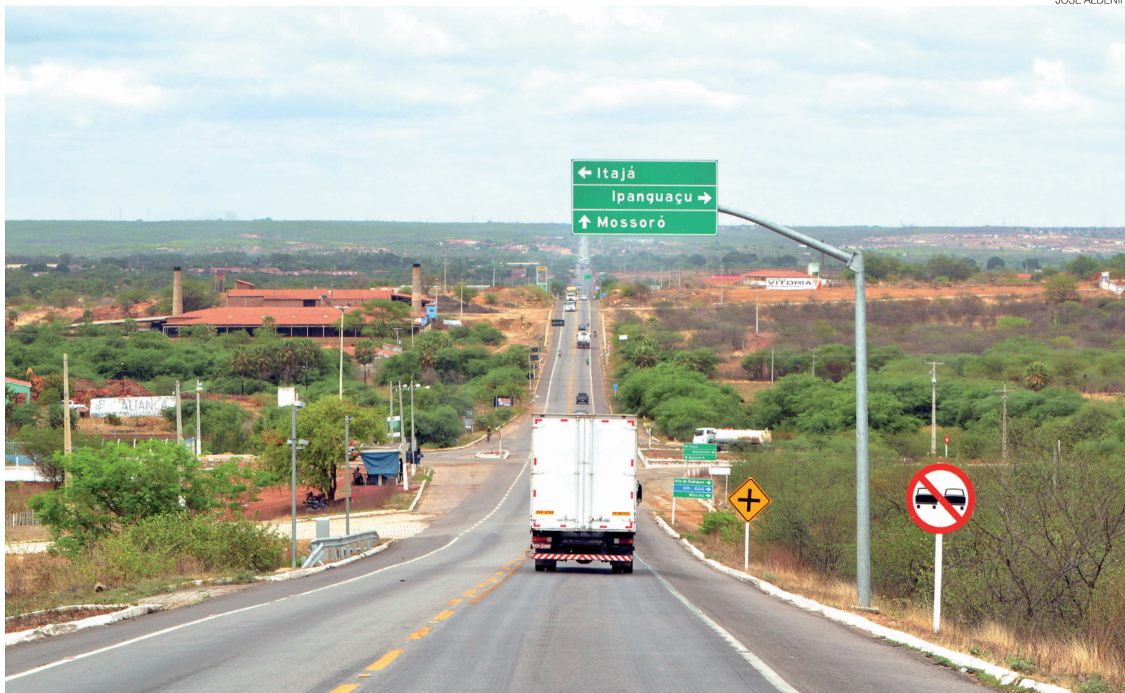
Trecho da BR-304 no interior do Rio Grande do Norte: rodovia liga Natal e Mossoró, as duas maiores cidades potigueras, e pode ser operadora por uma empresa
