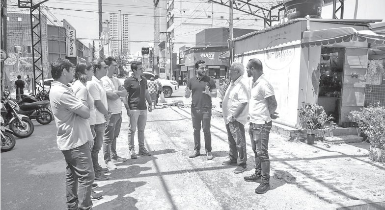
Vistoria realizada na via na última quinta por equipes da STTU e da Semsur
