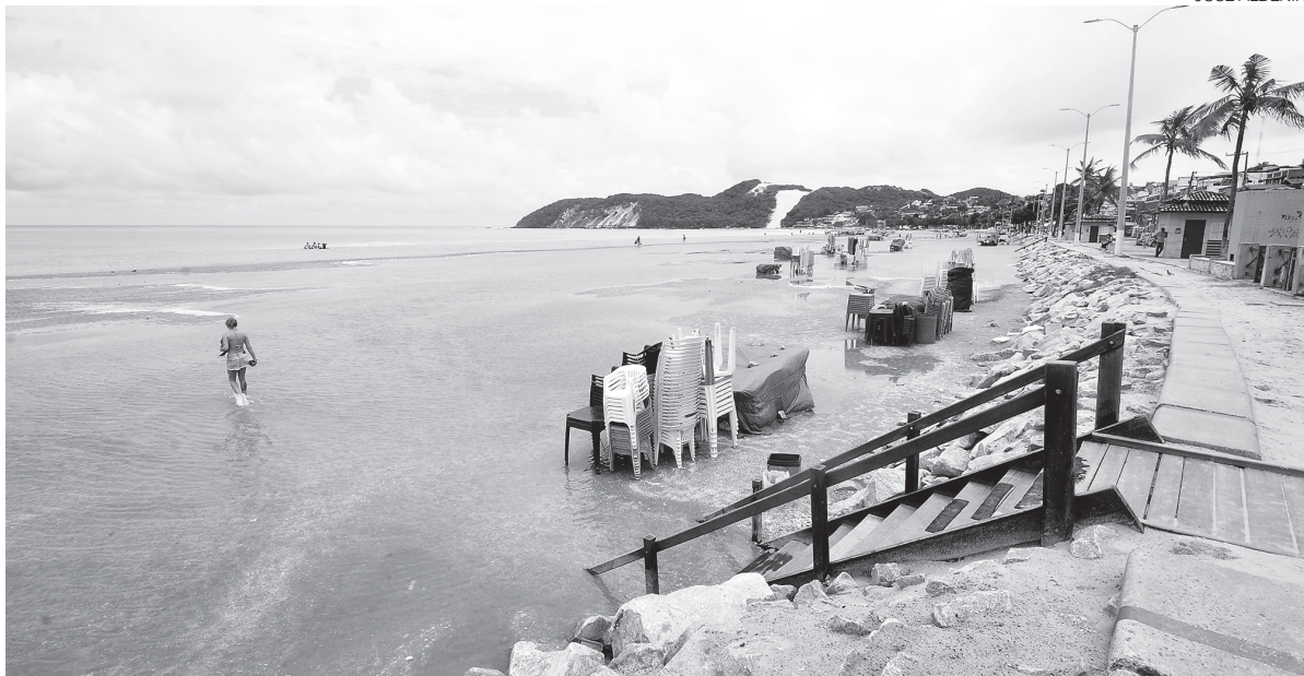
Com falhas na drenagem após engorda, praia de Ponta Negra convive com alagamentos em dias de chuva
