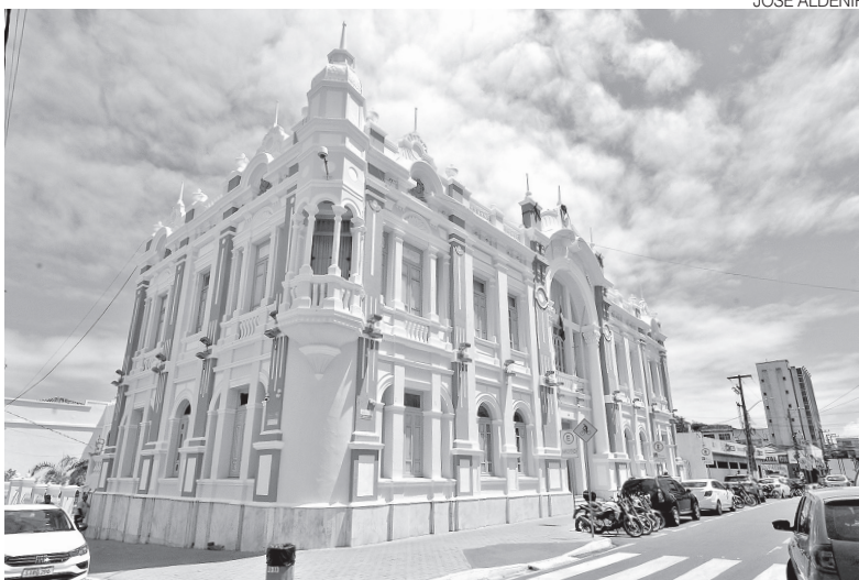
Gestão municipal busca recursos para construção de equipamentos da assistência
