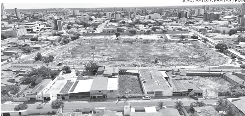
Vista aérea do antigo estádio Nogueirão logo após a realização da demolição
